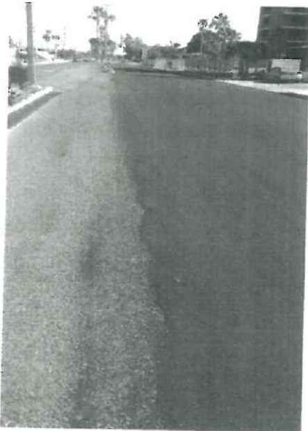
BACHEO Y RENIVELACION CON MEZCLA ASFALTICA
