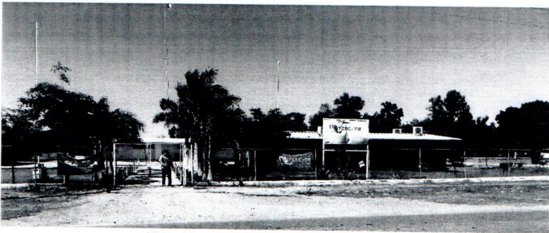
Vista del acceso principal del CECYTES Júpare
