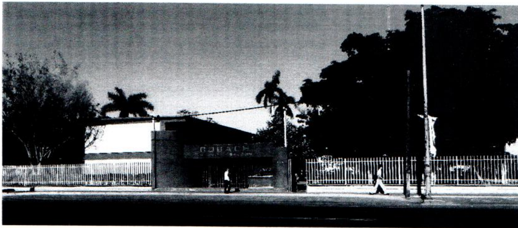
Vista exterior del COBACH Obregón 1
