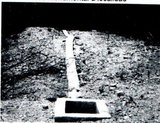
Encofrado y registro de conduccion de pozo
