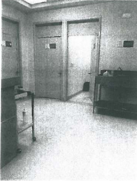
En esta fotografía se muestra pisos de loseta vinílica, muros y puertas.
