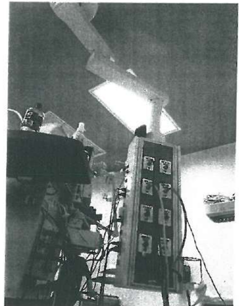
Brazo doble articulación para con sistema eléctrico, gases medicinales y de presión quirófano sencilla
