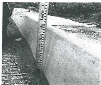
En esta fotografía se aprecia que se realizó la medición de la losa de pavimento de Concreto Hidráulico con resistencia  $F'c=250 \text{ kg/cm}^2$  TMA 40 mm.
