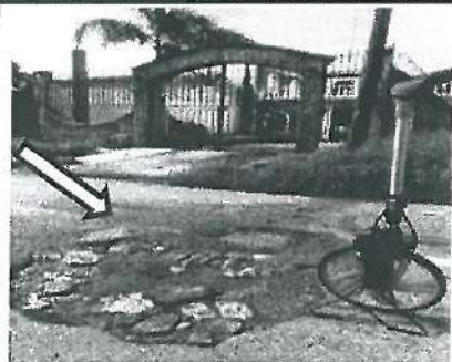
Bache de dimencion de 1.20 x 0.80 mts en la calle Jalisco entre No Relección y Garcia M.
