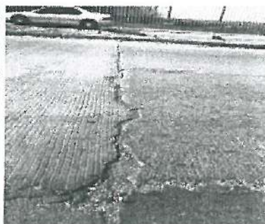
Mal corte uniforme en Losa de 20 cms de espesor en Concreto hidraulico, asi la falta de sello en la union de Junta.
