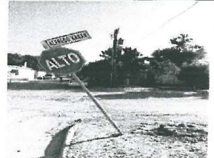
Cuenta Inclínación el poste del señalamiento restrictiva, Ubicado en Esquina de las calles Alfredo Karan y Venustiano Carranza.
