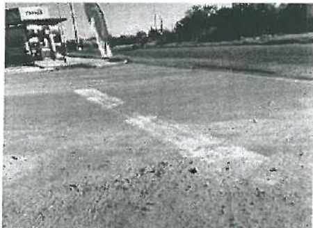
Desgaste en Pintura Tráfico Blanca con Esferilla, Indicadora de Alto, ubicada en Esquina de calle Revolución y Blvd. America.
