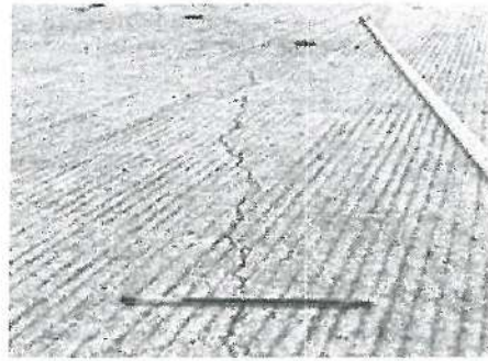
3 Grieta en Losa de Concreto de dimensión de 3.00 mts c/u, en la calle 21 de marzo entre Sexta y Kaly Mungaray.
