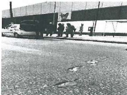
Detalles de Huellas en Losa de pavimento de Concreto Hidraulico con resistencia F'c=250 \text{ kg/cm}^2 TMA 40 mm
