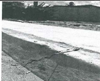
Grieta en Guarnición Banqueta, en calle Angostura y Pino Suarez
