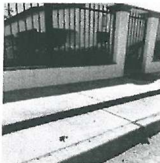
Grieta en Losa de Concreto de dimensión de 0.40 mts, en la calle Revolución entre calle 20 y calle 21.
