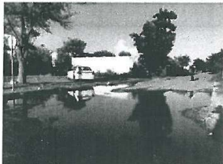
La calle presenta un desnivel de 3 cm, se recomienda a la Ejecutora la reparación por un daño a futuro, que se puede presentar a la carpeta, se ubica al principio de la calle Novena y Periferico.
