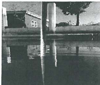
La calle presenta un desnivel de 3 cm, se recomienda a la Ejecutora la reparación por un daño a futuro, que se puede presentar a la carpeta, se ubica al principio de la calle Novena y Periferico.
