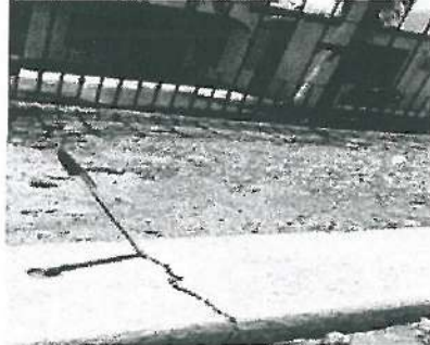
Grieta en Guarnición no.2
