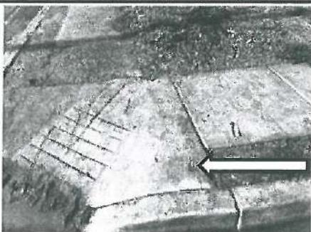
Daño en banqueta por letras plasmada en la banqueta, en esquina de calle Jose M. Leyva y Bacoachi.
