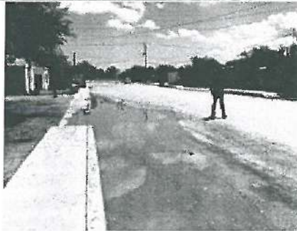
La calle presenta un desnivel de 4 cm en uno costado, una dimension de 20 x 4 mts, se recomienda a la Ejecutora la reparación por un daño a futuro, que se puede presentar la losa de concreto, ubicada en calle 2 de Abril y Francisco Villa.
