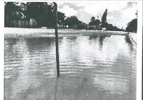
La calle presenta un desnivel de 4 cm en uno costado, una dimension de 20 x 4 mts, se recomienda a la Ejecutora la reparación por un daño a futuro, que se puede presentar la losa de concreto, ubicada en calle 2 de Abril y Francisco Villa.
