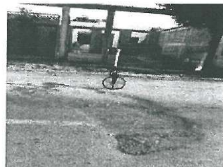
Bache de dimencion de 2.50 x 2.00 mts, ubicado en la calle cuarta entre avenida y Periferico.
