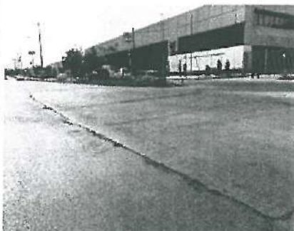
Mal corte uniforme en Losa de 20 cms de espesor en Concreto hidraulico, asi la falta de sello en la union de Junta.
