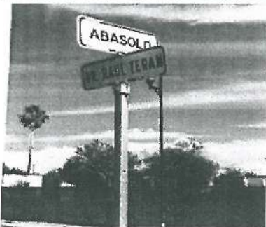
Falta Lamina de señalamiento restrictiva (alto sr-6) de 61x61 cm. En esquina Oriente de calle Abasolo y Dr. Raúl Teran.
