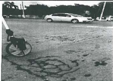
2 Baches de dimensiones de 2.0 x 3.00 y 0.30 x 0.30 mts en esquina de la Blvd. Almada y Calle Amadonervo.
