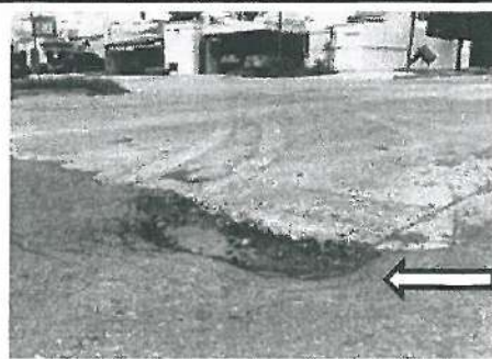
Bache de dimencion de 1.80 x 1.00 mts en esquina de la calle Jalisco y Garcia Morales.
