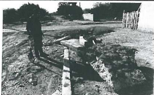
Falta 1 señalamiento restrictiva (alto sr-6) de 61x61 cm. Arrojando un Monto faltante en Obra de $2,766.92 S/IVA
