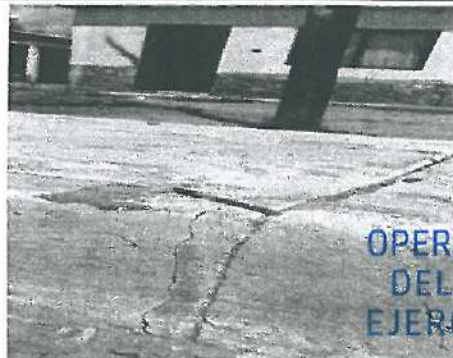
Grieta en Guarnición Banqueta, ubicada en calle 2 de Abril y Francisco Villa.
