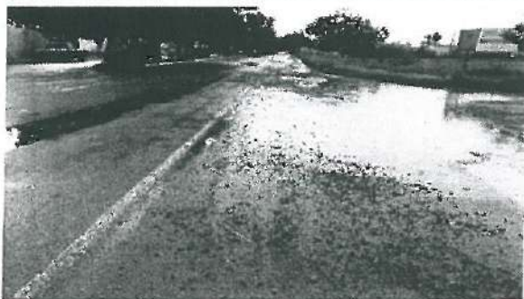
Falta Limpieza en el Blvd. Brisas del Valle.
