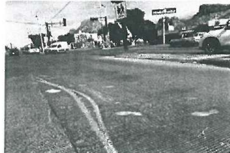
Detalles de Huellas en Losa de pavimento de Concreto Hidraulico con resistencia F'c=250 \text{ kg/cm}^2 TMA 40 mm
