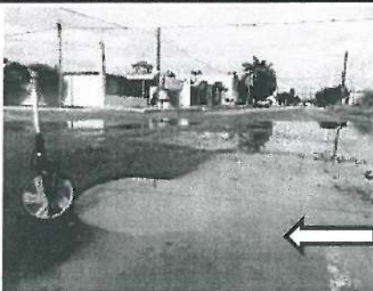
Bache de dimencion de 0.80 x 0.60 mts en esquina de la calle Jalisco y Antonio Rincon.
