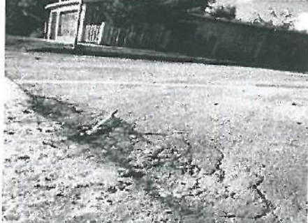
Bache de dimensión de 1.50 x 0.30 mts en la esquina de las calles Emiliano Zapata y 5 Mayo.
