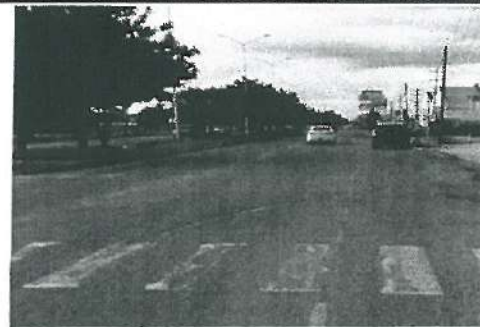
Desgaste en vialeta doble cara amarilla en rayas de acotamiento @ 30.0 mts Blvd. Almada y calle jalisco.
