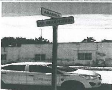
Falta 2 Lamina de señalamiento restrictiva (alto sr-6) de 61x61 cm. En esquina Poniente y Oriente de calle Abasolo y Gral. Ignacio Pesqueira.
