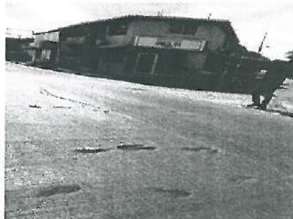
Detalles de Huellas en Losa de pavimento de Concreto Hidraulico con resistencia F'c=250 \text{ kg/cm}^2 TMA 40 mm
