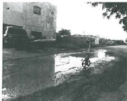
La calle presenta un desnivel de 3 cm, se recomienda a la Ejecutora la reparación por un daño a futuro, que se puede presentar a la carpeta, se ubica al principio de la calle Novena y Periferico.
