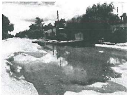
La calle presenta un desnivel de 3 cm, se recomienda la reparación por un daño a futuro, que se puede presentar a la carpeta, se ubica al final de la calle Allende y Victor Sila Duran.
