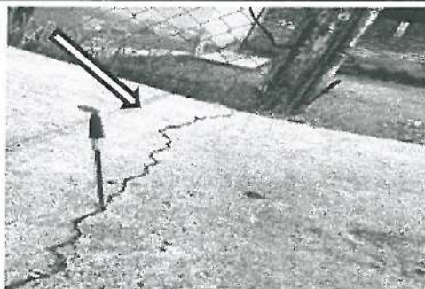
2 Grietas en Banqueta la cual tiene 1 metro lineal. C/u en la calle Ramon Teran (Frente de Iglesia)
