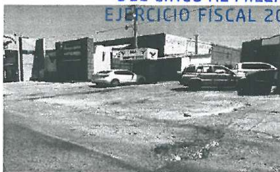
Baches en Microcarpeta de 3.0 cm (Ubicado Enfrente Negocio de Leche Yaqui)
