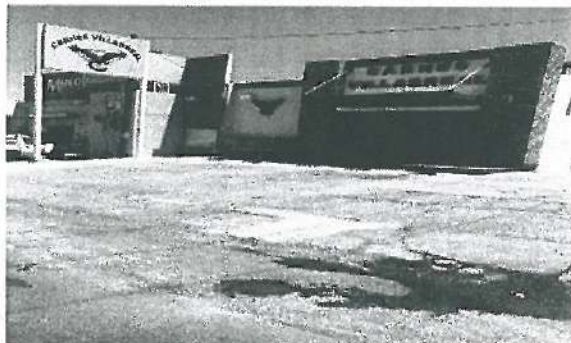
Baches en Microcarpeta de 3.0 cm ( Ubicado Enfrente Negocio de Carniceria Villarreal)
