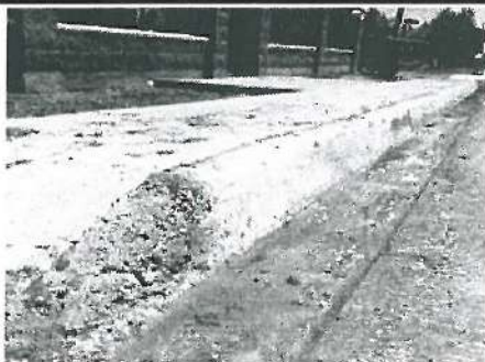
Guarnición sin acabado Final, en calle Angostura y Pino Suarez
