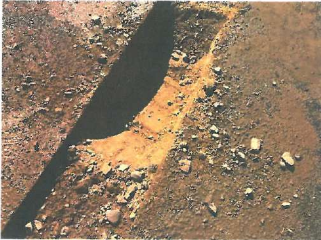
EXTRACCION DE BASE HIDRAULICA DE ESTE TRAMO 3+680 DONDE NO SE TRABAJO BASE PARA DETERMINAR SU CALIDAD Y COMPARARLA CON LA DEL BACHE QUE FUE EN EL TRAMO 3+500
