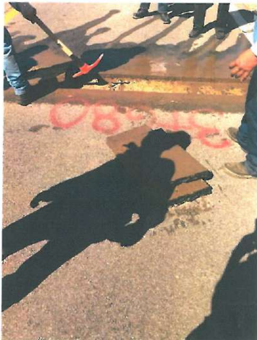
LEVANTAR LA SUPERFICIE CORTADA
