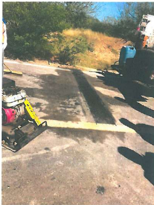
AL TERMINO DE LA ACTIVIDAD SE PROCEDIO A TAPAR Y DEJAR LA SUPERFICIE LISTA PARA SU TRANSITO.
