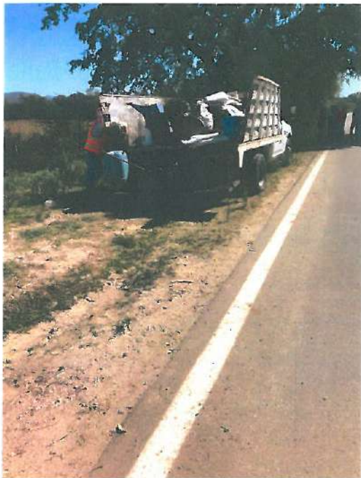
EQUIPO Y MATERIAL PARA EL TAPADO DE LAS FRANJAS
