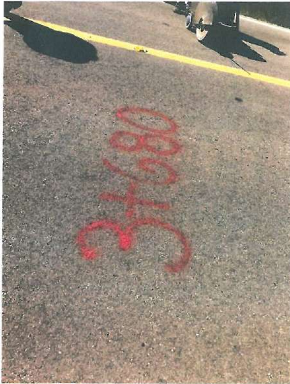
MARCADO DEL CADENAMIENTO
