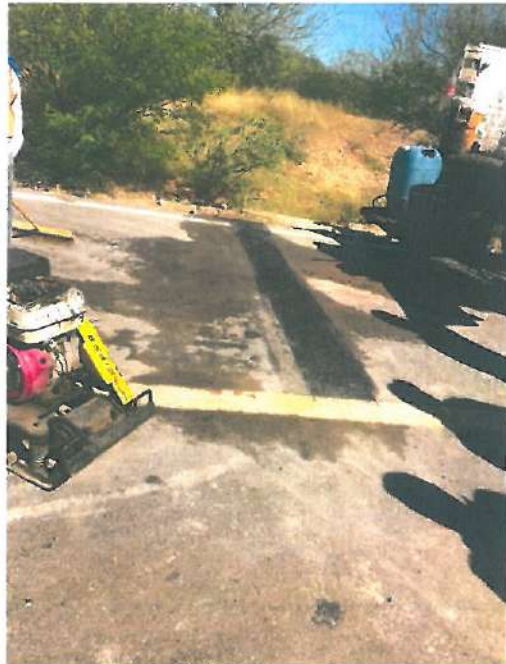
AL TERMINO DE LA ACTIVIDAD SE PROCEDIO A TAPAR Y DEJAR LA SUPERFICIE LISTA PARA SU TRANSITO.
