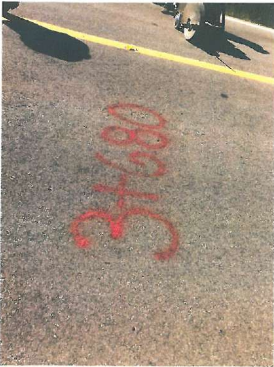
MARCADO DEL CADENAMIENTO
