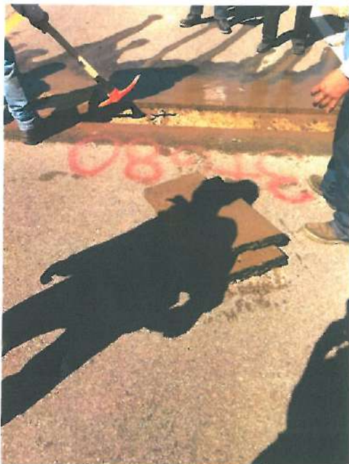
LEVANTAR LA SUPERFICIE CORTADA
