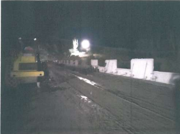
Área de Dique, -colocación de concreto CCR
