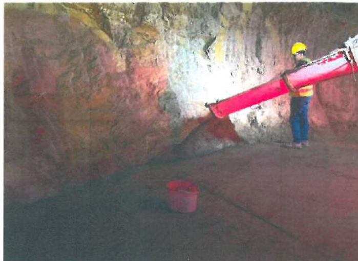
Relleno fluido en laterales de Dique
