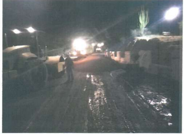
Área de Dique, -colocación de concreto CCR
