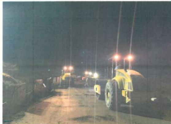
Compactacion de concreto CCR
