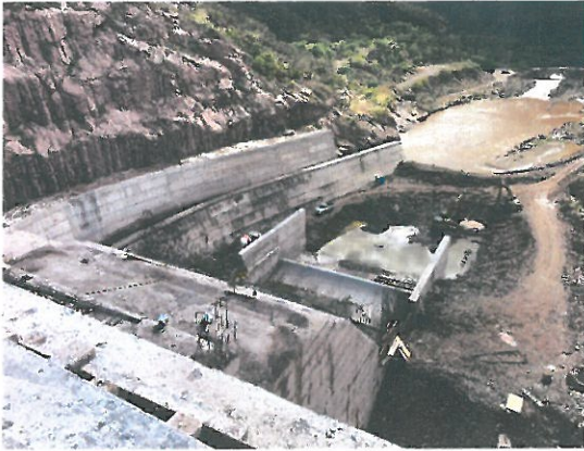
Obra de desvío
