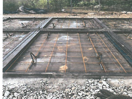
Cimbra de Escamas en Dique
