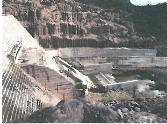
Cortina y obra de desvío
