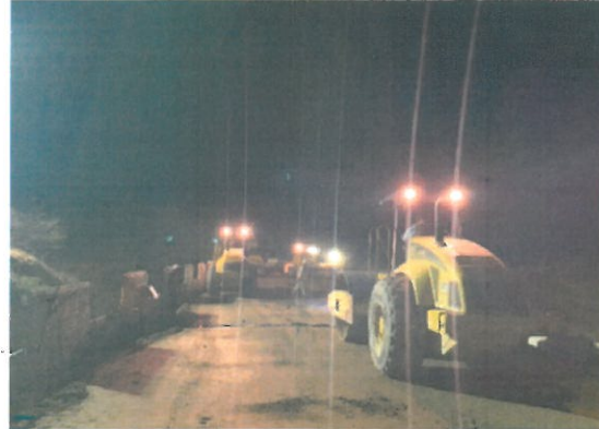
Compactacion de concreto CCR
