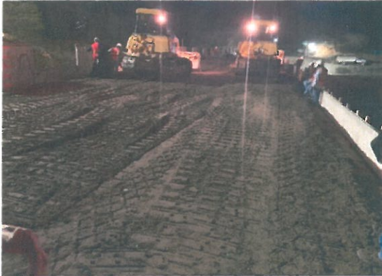
Colocacion de concreto CCR
