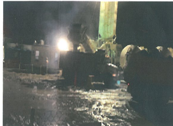
Carga de Concreto CCR
