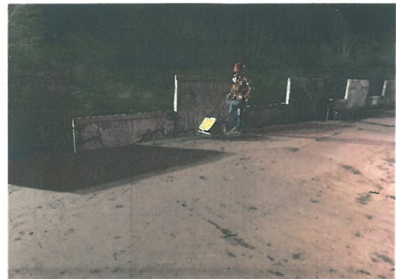
Disipadores de concreto
