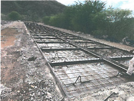
Cimbra de Escamas en Dique
