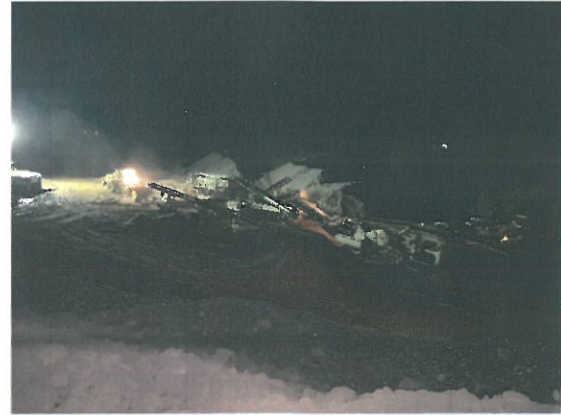
Criba de agregados
