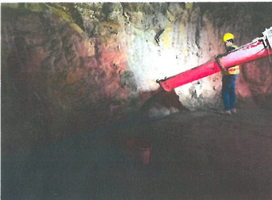
Relleno fluido en laterales de Dique
