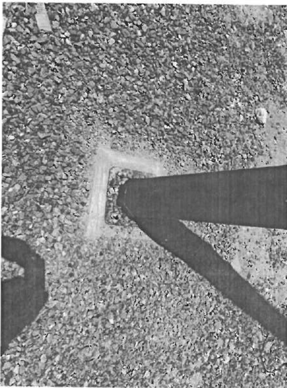
Colocacion de base prefabricada de concreto 70X60X40, colocacion de poste cónico circular de 8 mts, instalación de luminaria led de 80 watts
