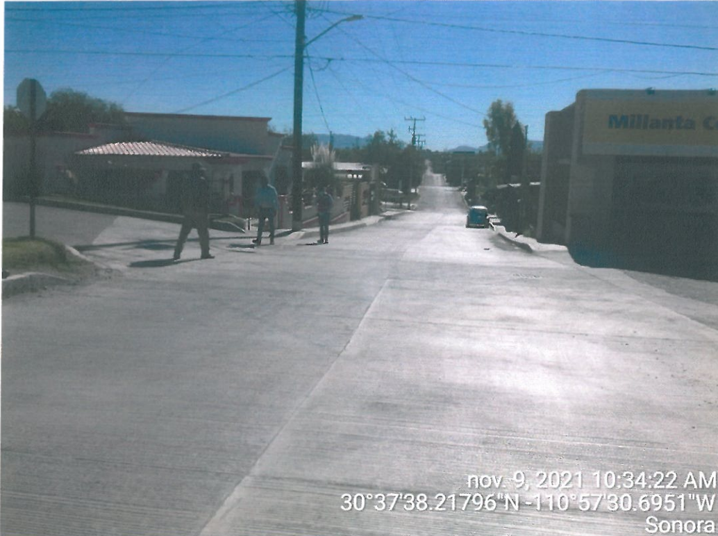
Extracción y medición de corazón de concreto endurecido y panorámica de avenida Jesus Garcia Corona.
