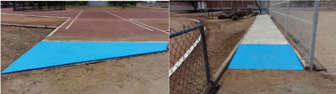
Rampas y Banquetas Terminadas
