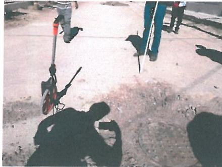
**las fotografías muestran la medición de las longitudes de las calles donde fue colocada la tubería, verificando las distancias entre pozo y pozo.**
