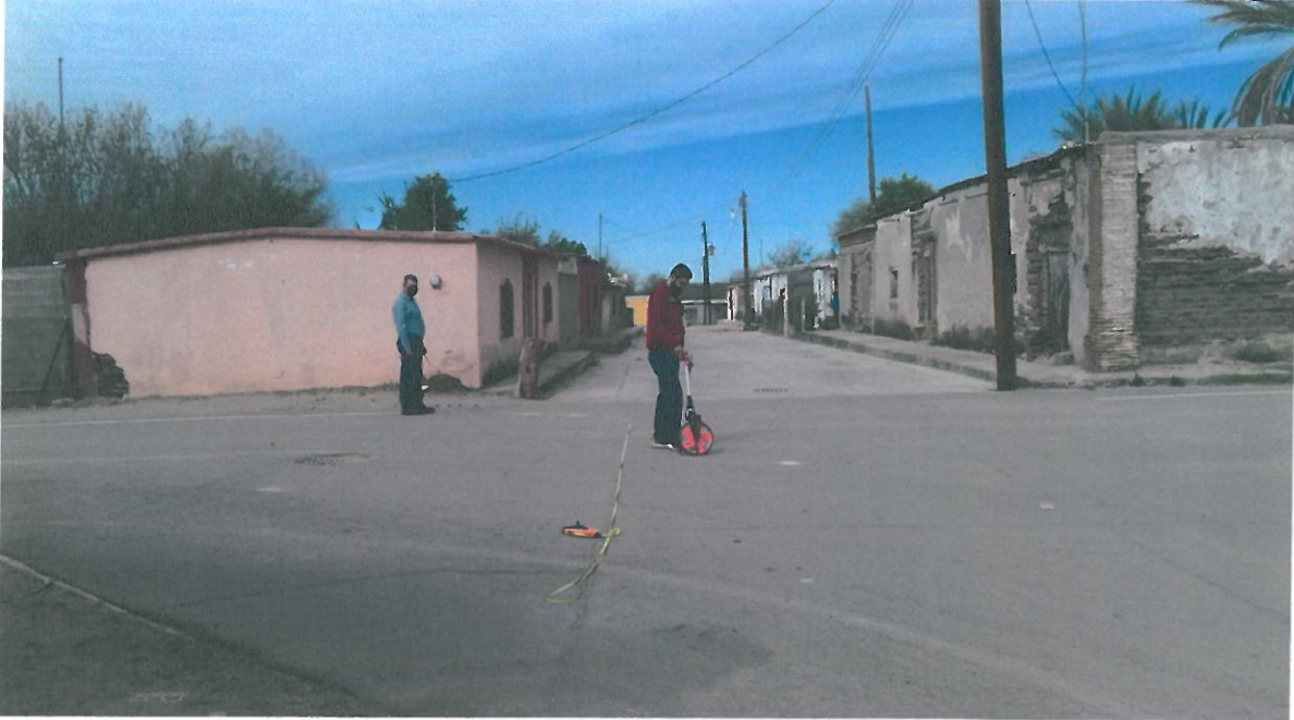
MEDICION DE AREAS, DE CARPETA ASFALTICA, EN CALLES Y AVENIDAS.
