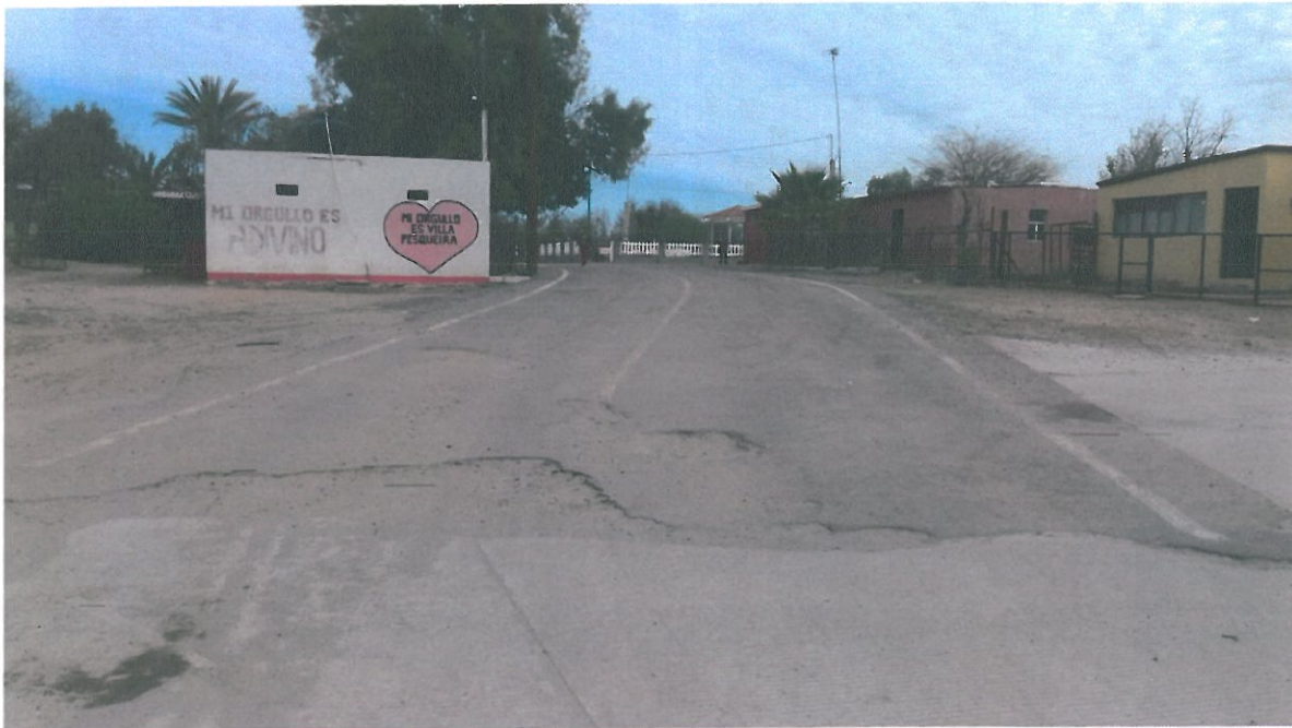
CARPETA ASFALTICA Y ALINEAMIENTO HORIZONTAL (RAYA BLANCA Y AMARILLAS), EN CALLE ACCESO A PLAZA.
