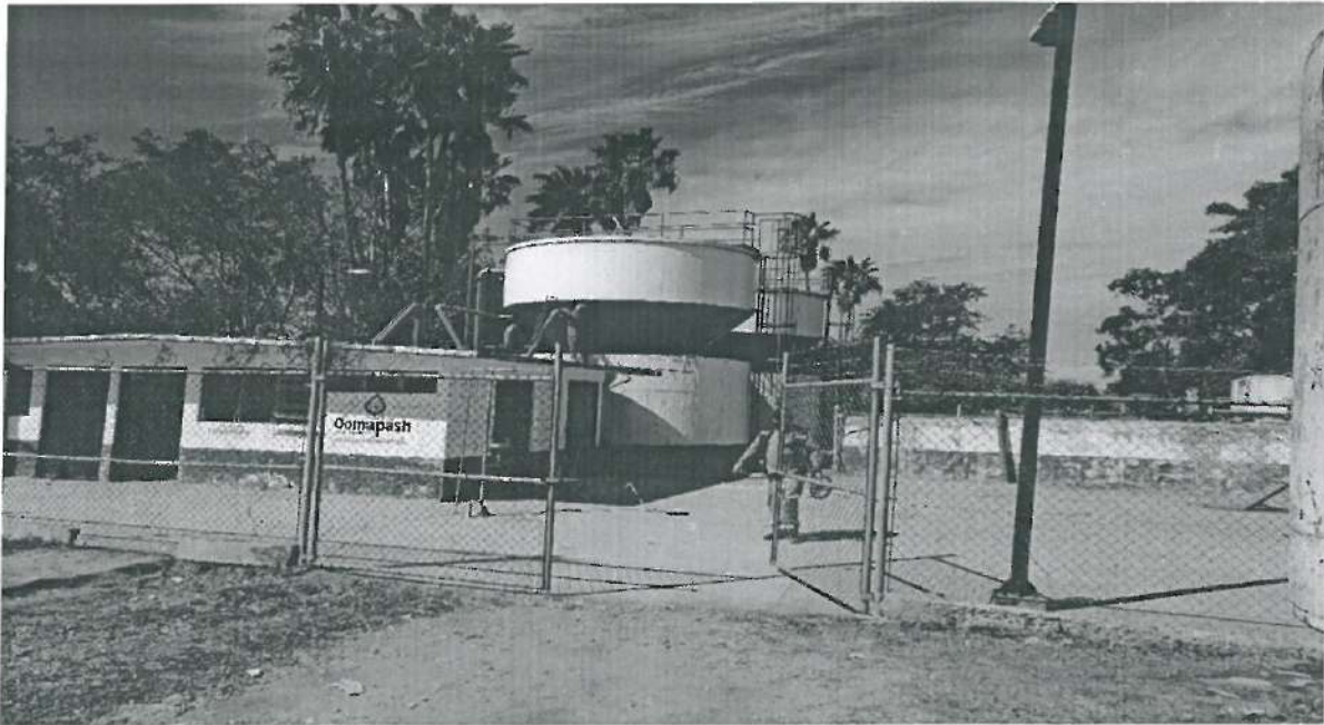
Vista panorámica del sitio de la obra
