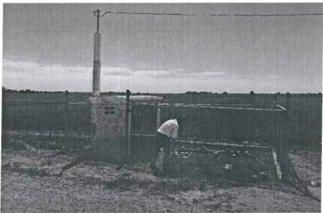
Caseta de proteccion de planta generadora
