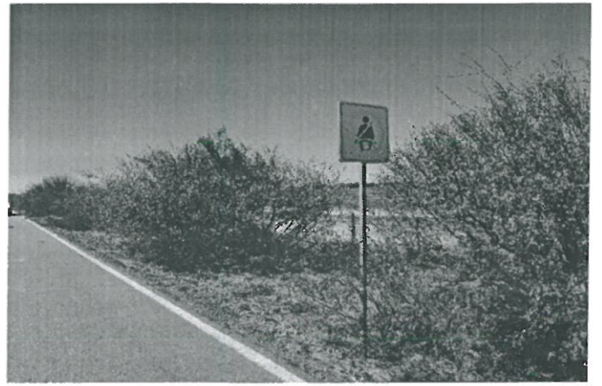
Colocación de señalamiento de 71 X 71 cm.
