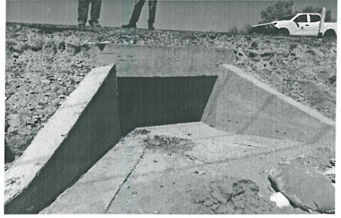
Concreto hidraulico en losas de muros y aleros.
