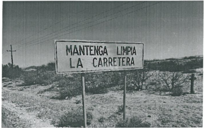
Suministro y colocación de señalamiento señales informativas de recomendación
