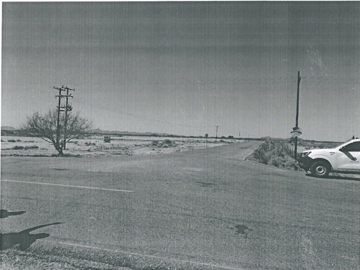
Vista panorámica del sitio de la obra.
