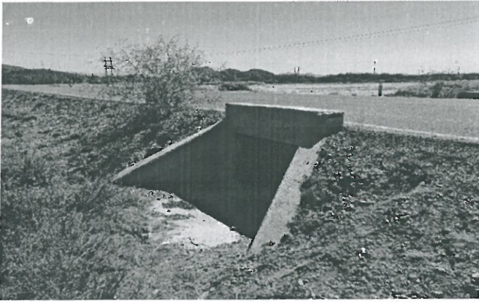
Concreto hidraulico en losas de muros y aleros.
