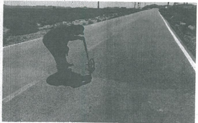
Construcción de carpeta de concreto asfáltica.
