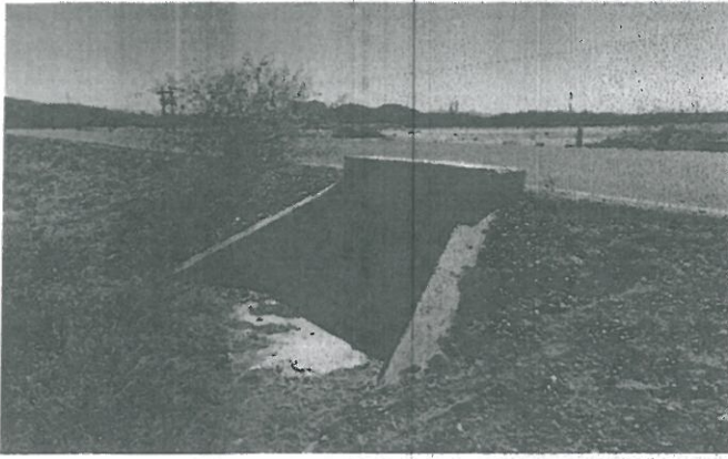
Concreto hidráulico en losas de muros y aleros.
