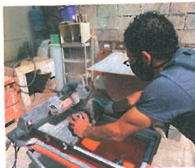
Etapa Desprendimiento de Material en carpeta de forma manual y maquina de corte.
