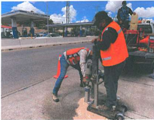
Etapa de Extracciones de Núcleos de Concreto, utilizando broca de 4"
