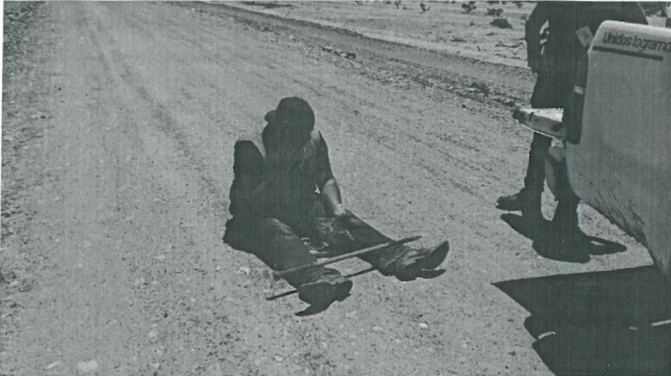
REALIZACION DE CALAS PARA DETERMINAR EL GRADO DE COMPACTACION, EN CAPA DE TERRAPLEN.
