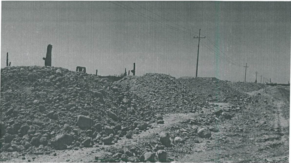
SE APRECIA SUMINISTRO DE MATERIAL DE SUBRASANTE CON SOBRETAMAÑO
