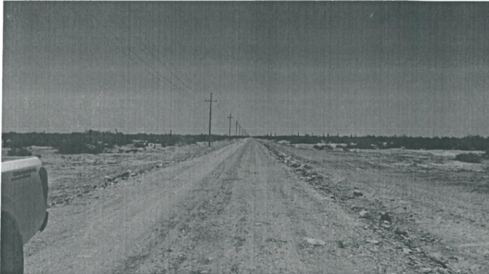
SE APRECIA CAPA DE TERRAPLEN
