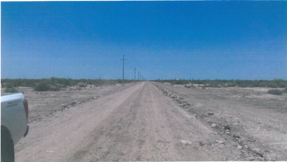
SEAPRECIA CAPA DE TERRAPLEN
