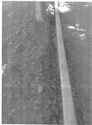
Colado de guarnición tipo I
