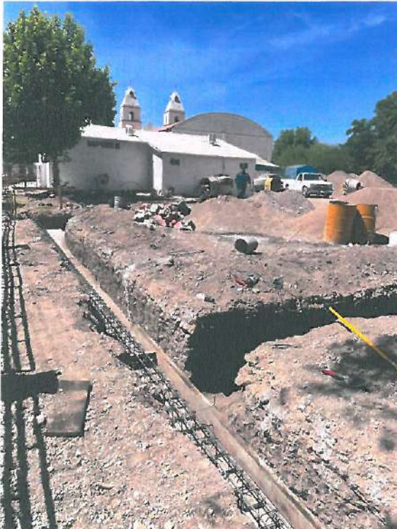
COLOCACION Y ARMADO DE ZAPATAS CORRIDAS Y AISLADAS EN PLANTILLA DE CONCRETO POBRE F'C 100 KG/CM 3
