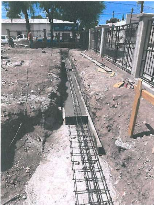
COLOCACION DEL CONCRETO CRETO EN ZAPATAS CORRIDAS Y ZAPATAS AISLADAS
