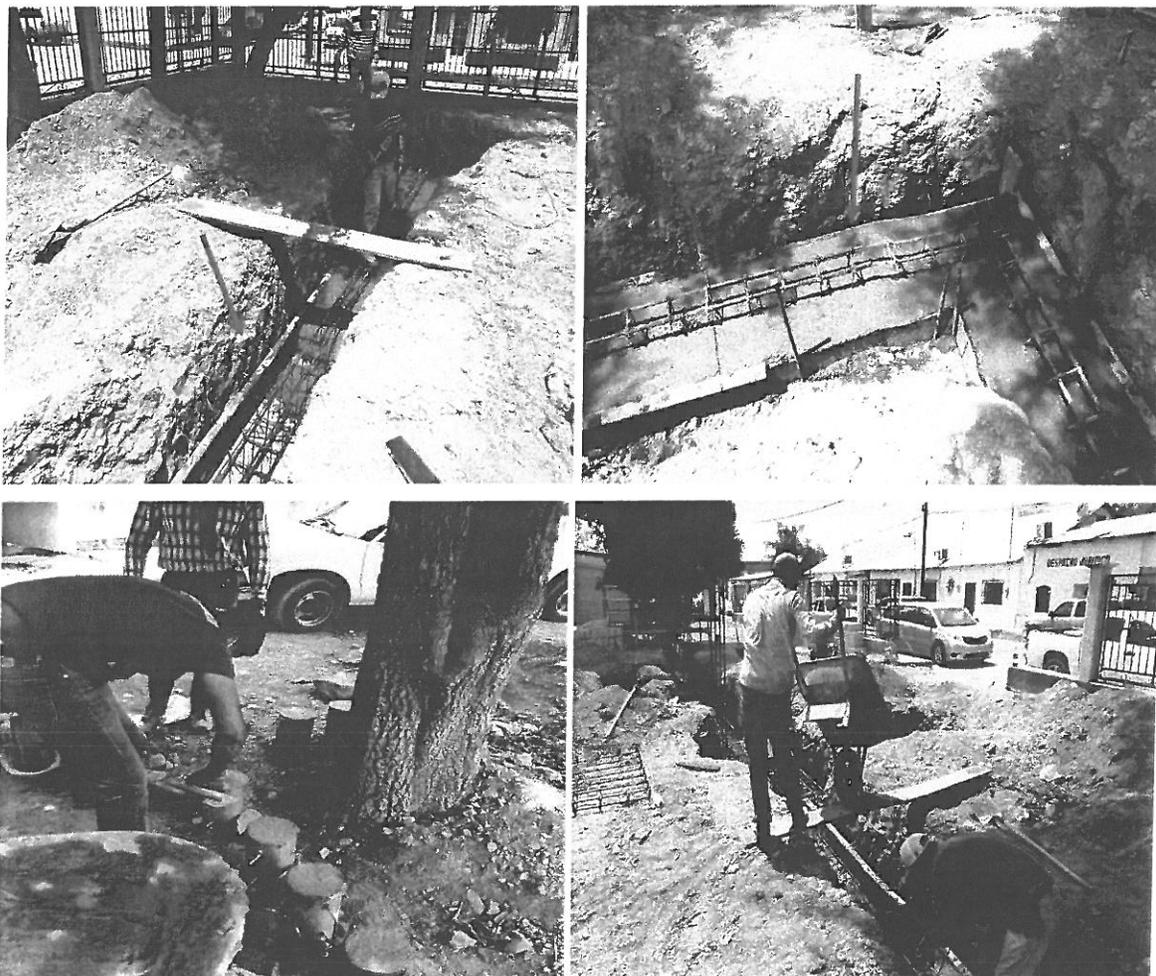
Se realizó el recorrido de la obra la cual se encontraba en armado de cimbra en zapata para recibir colado de concreto, posteriormente, el personal de SCG tomó muestra para su ensayo en laboratorio.
