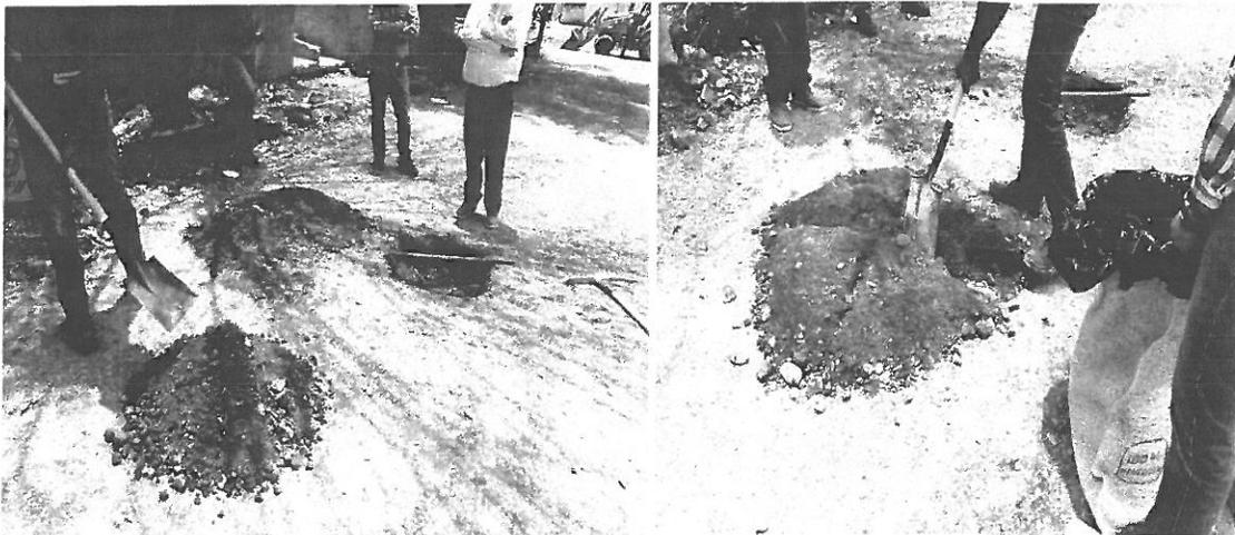
Se realizó el recorrido de la obra la cual se encontraba proceso de nivelación y homogenización de material de base en calles de contrato SIDUR-ED-20-162, personal de SCG procedió a toma de muestra en todo el espesor de la capa para su análisis en laboratorio.
