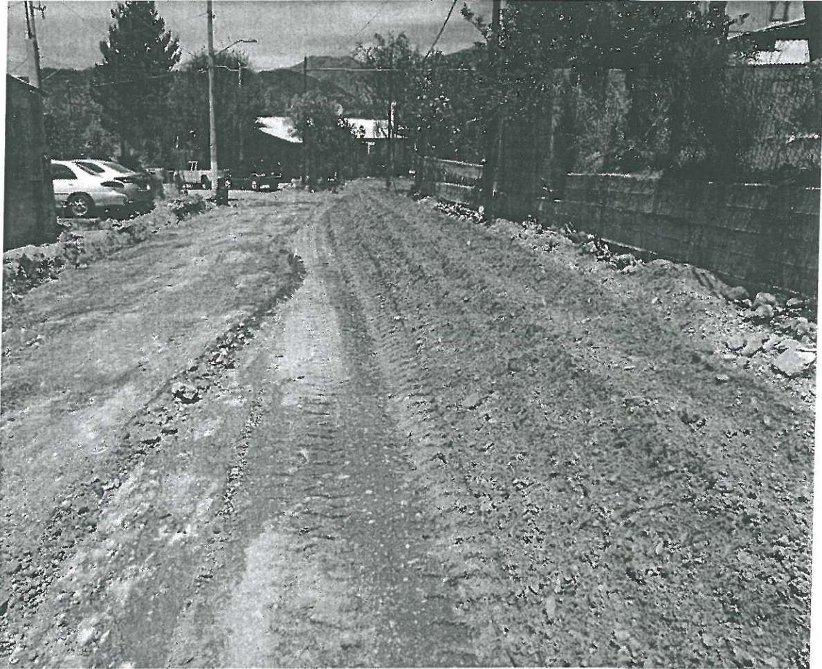
VISTA PANORAMICA DE LA OBRA
