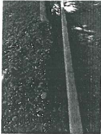
Colado de guarnición tipo I
