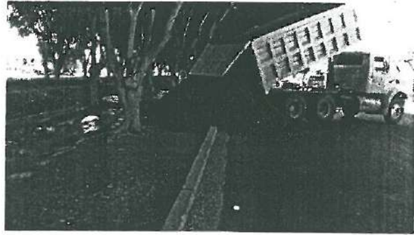
Acarreo de material inerte para relleno
