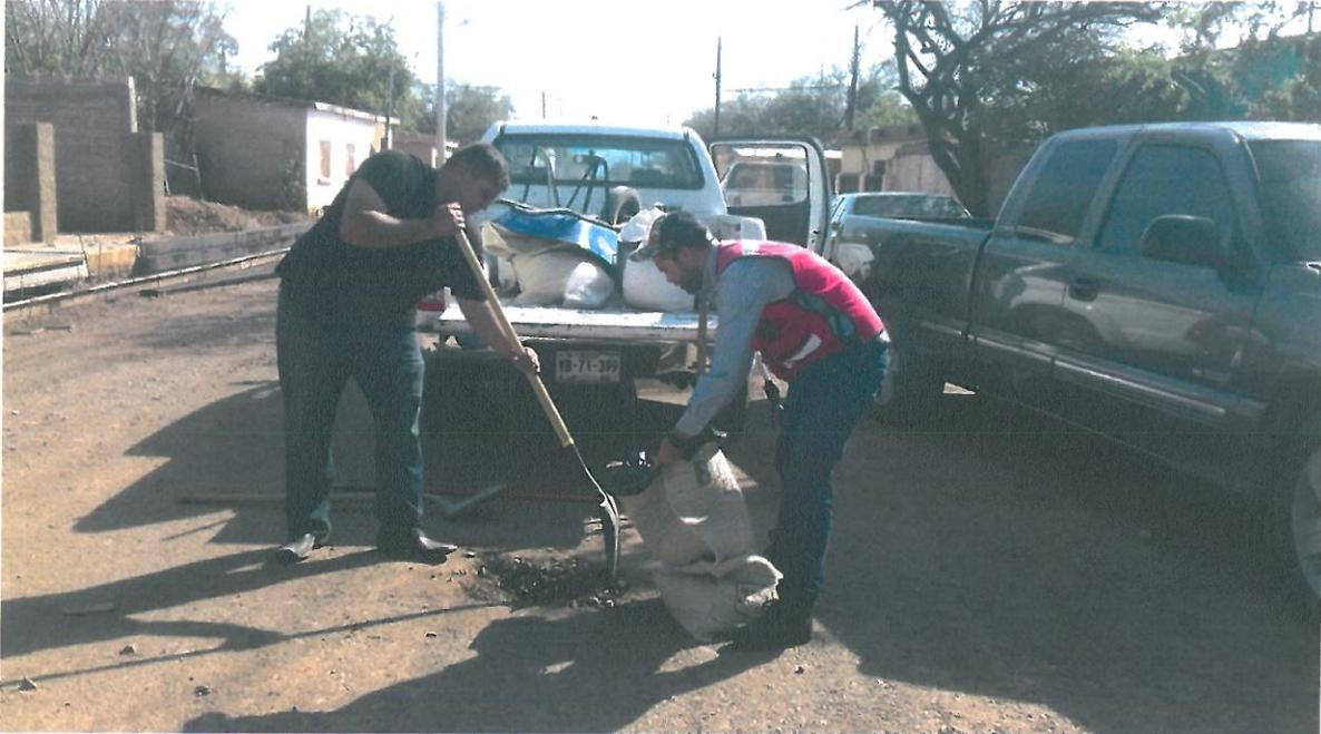
TOMA DE MUESTRA DE BASE HIDRAULICA, PARA DETERMINAR SU CALIDAD.
