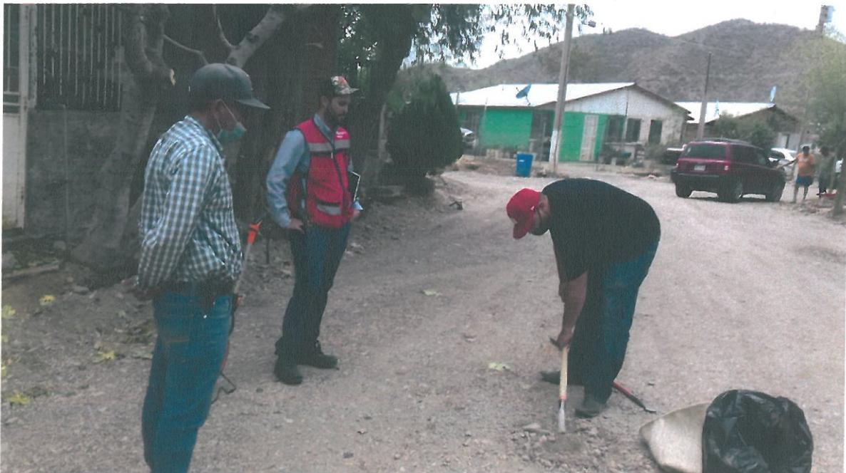
PREPARACION PARA COLADO DE LOSA DE PAVIMENTO Y TOMA DE MUESTRA DE BASE HIRAUICA EN CALLE DEL ROBLE.
