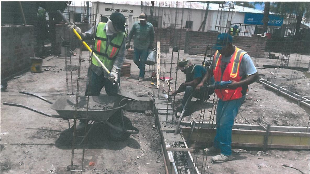
ELABORACION DE CILINDROS DE CONCRETO PARA DETERMINAR SU RESISTENCIA Y COLADO DE CADENAS DE DESPLANTES.
