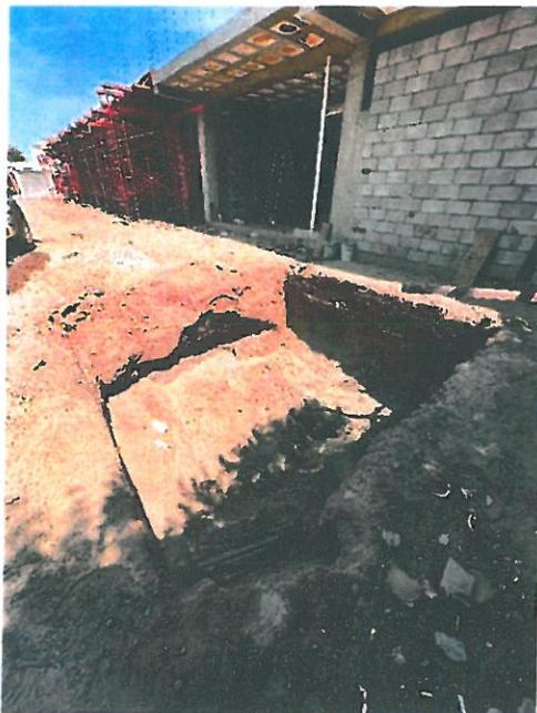
COLOCACIÓN DE CIMBRA PARA COLADO DE COLUMNAS DE SEGUNDA PLANTA
