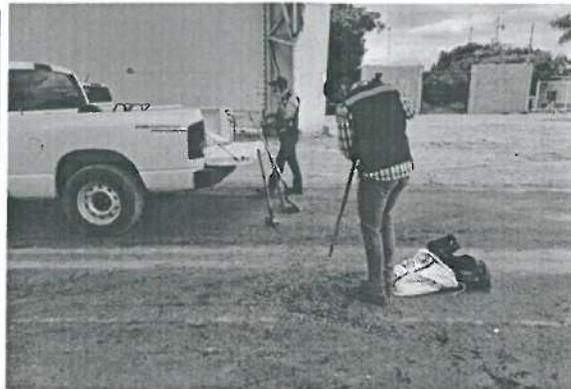
Se realizó el recorrido de la obra la cual se encontraba conceptos en proceso de afinado en material de base recuperado adicionado con oxido de calcio del 1% en cadenamiento 0+260 al 0+530, del cual se muestreó para su análisis en laboratorio; colocación de subrasante en punto de verificación oriente en cadenamiento 0+165 al 0+180.
