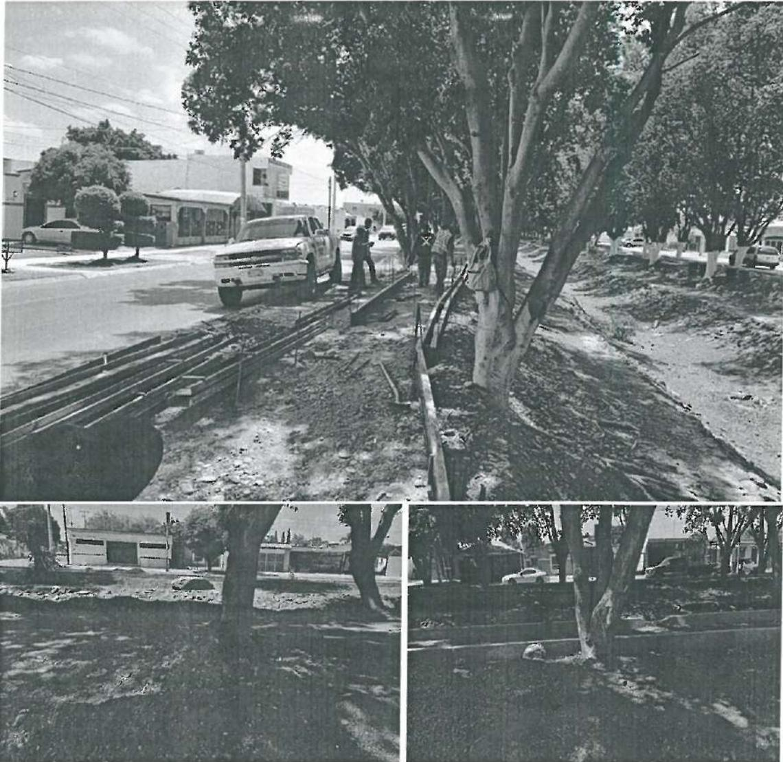
Se realizó el recorrido de la obra la cual se encontraba conceptos en proceso de armado de cimbra para recibir colado de guarnición ubicado en lado sur en segunda sección. Además se encontraron trabajos de relleno y compactación de material inerte en área de andador en sección 4 (lado norte y sur) y sección 5.
