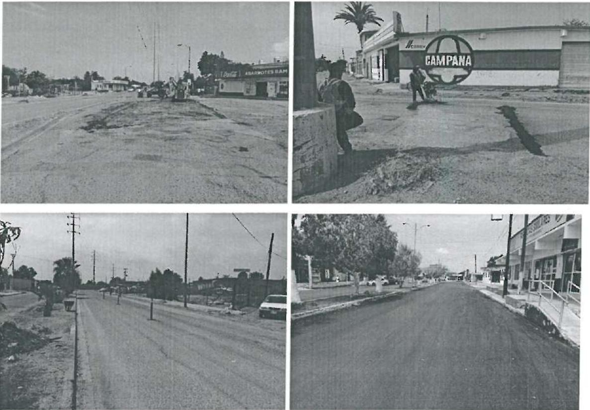
Se realizó el recorrido de la obra la cual se encontraba conceptos en proceso de barrido y retiro de material, además se encontró trabajos de bacheo en áreas dañadas en cruces y vialidades.
