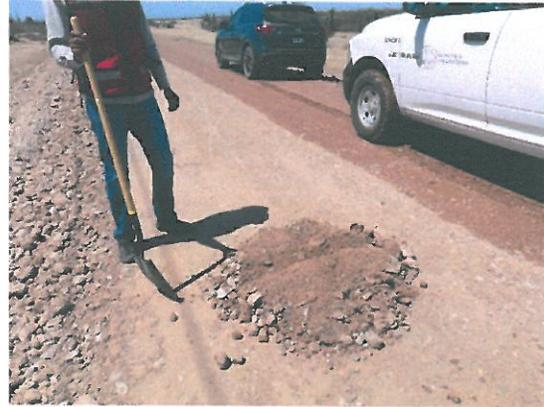
Una vez realizados los cajones correspondientes se procedió a traspalear y homogenizar la muestra para después cuartear y colocar en su saco; para ser evaluado en el laboratorio
