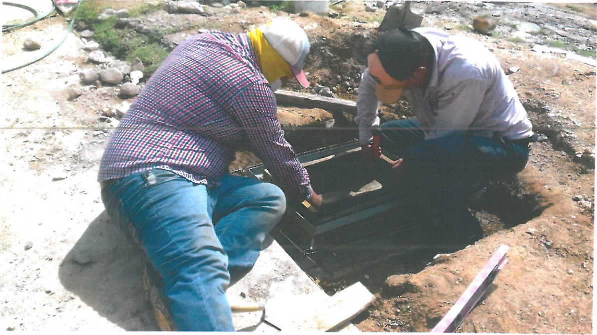
EJECUCION DE REGISTRO SANITARIO
