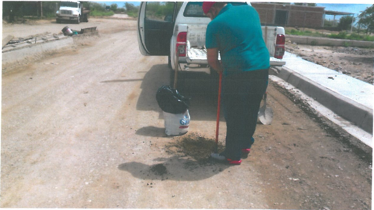
TOMA DE MUESTRAS DE LA CAPA DE BASE HIDRAULICA , EN AMBOS CUERPOS, PARA DETERMINAR SU CALIDAD.
