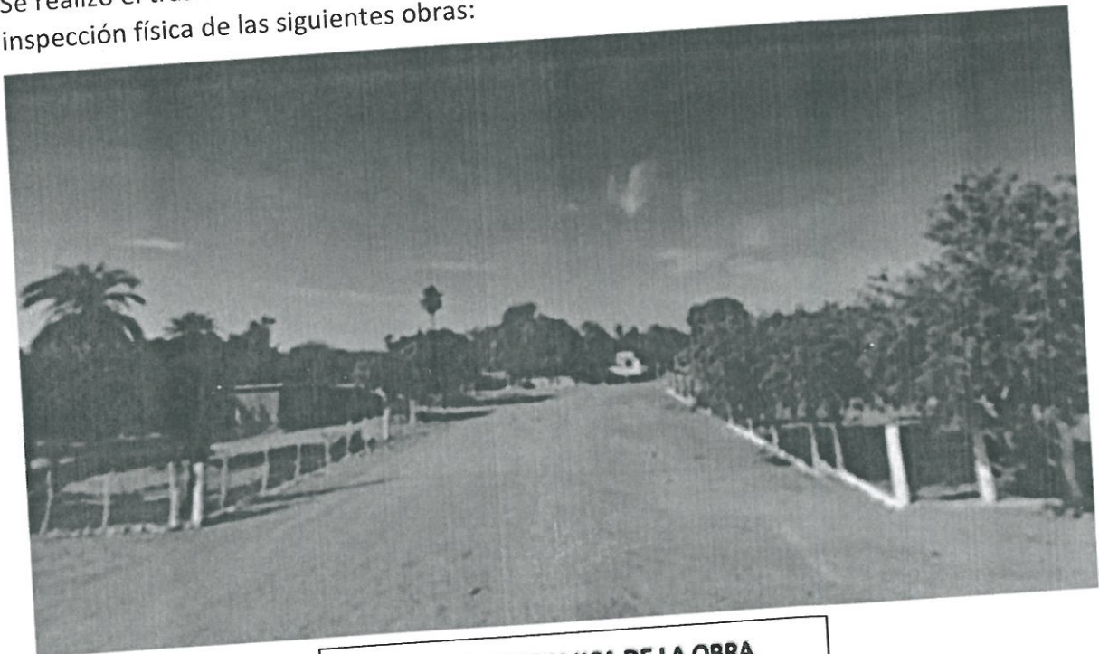
VISTA PANORAMICA DE LA OBRA
