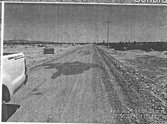
En la verificación física, se procedió a la revisión de la capa de material de revestimiento, el cual se tiene tendida hasta el cadenamiento 2+300 conformada por 15 cm. Se procedió a toma de muestra de material de revestimiento en cadenamiento 0+820 del cual representa del cadenamiento 0+720 al 1+120. La muestra se tomó para su análisis en laboratorio, realizando un cajón de 40 x 40 cm en todo el espesor de la capa, la cual cumple con los 15 cm contemplados.
