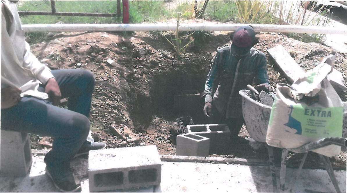
EJECUCION DE REGISTRO SANITARIO
