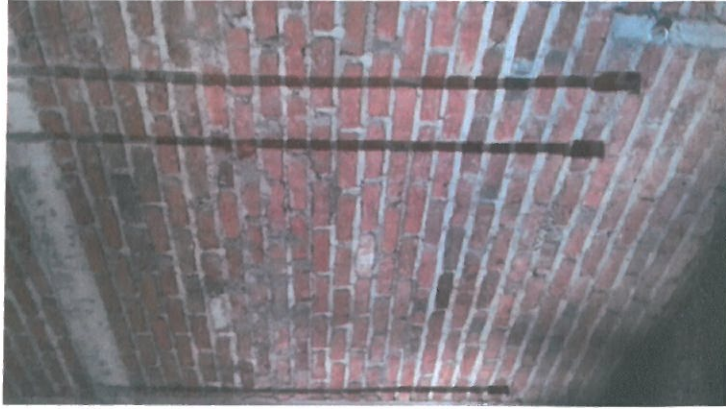
SE APRECIA PREPARACION PARA DUCTOS Y VENTILAS, EN LOSA DE AZOTEA.
