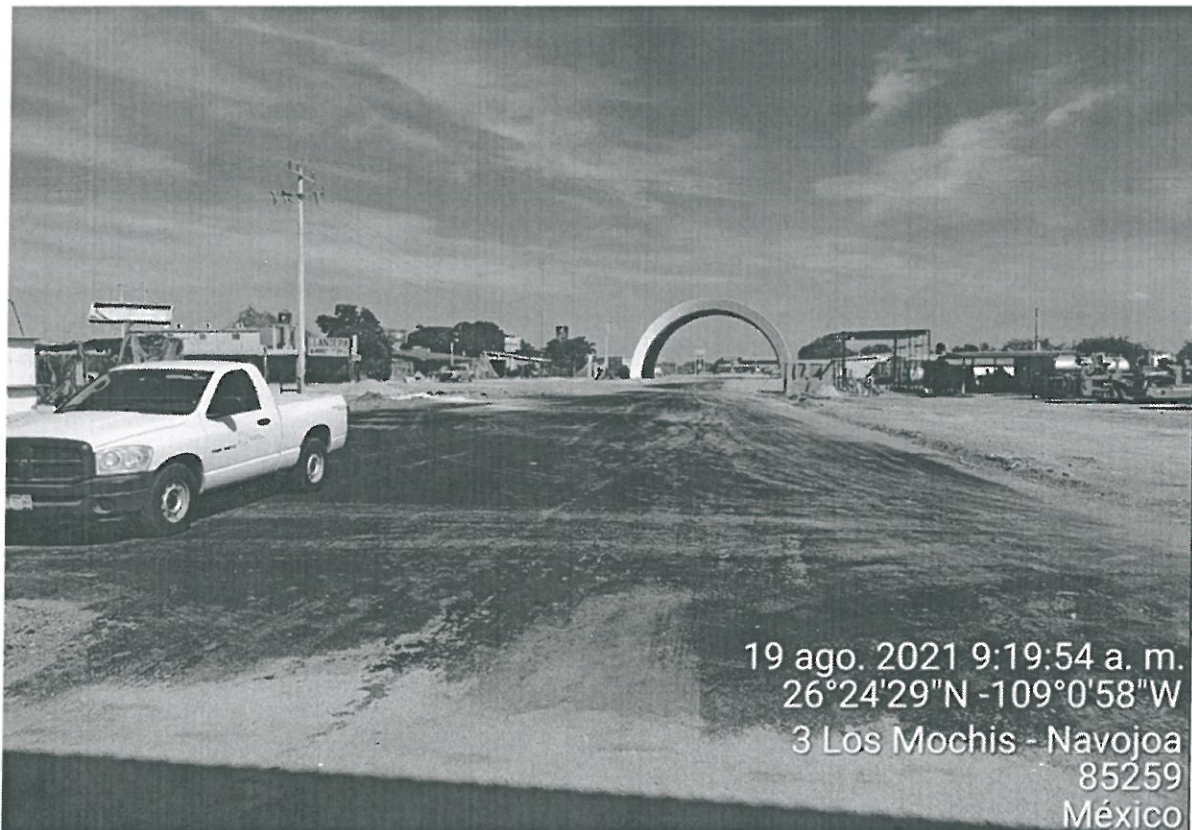
VISTA PANORAMICA DE LA OBRA
