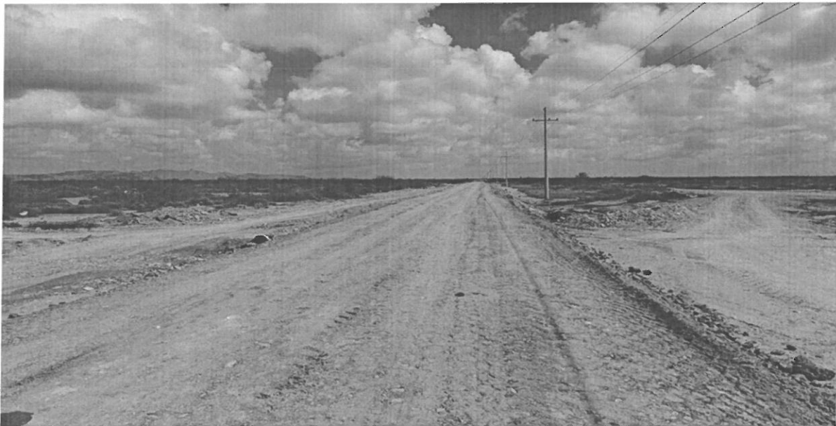
VISTA PANORAMICA DE LA OBRA
