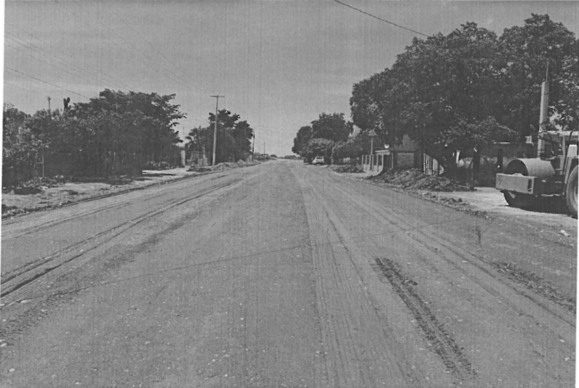
VISTA PANORAMICA DE LA OBRA
