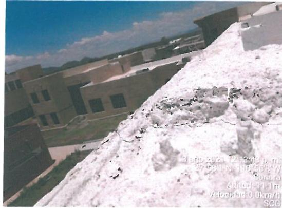
Imágenes mostrando que las grietas recorren todo el muro llegando hasta la parte de la azotea.
