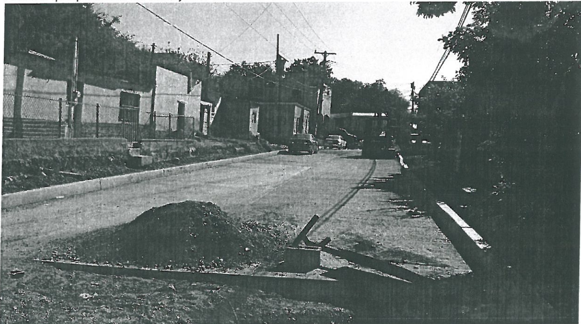
LOSA DE CONCRETO HIDRAULICO EN PAVIMENTO
