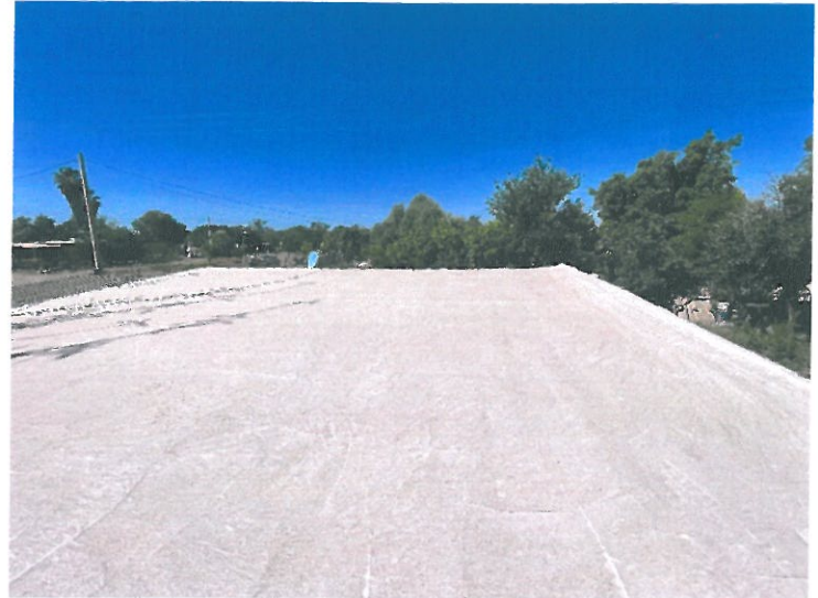
VISTA DE TECHUMBRE DE CUARTO DROMITORIO
