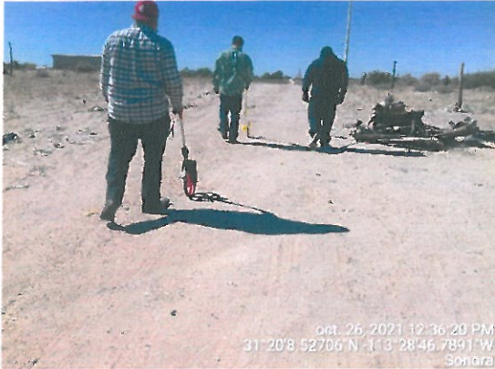
Medición de línea de agua y ubicación de caja de valvula.
