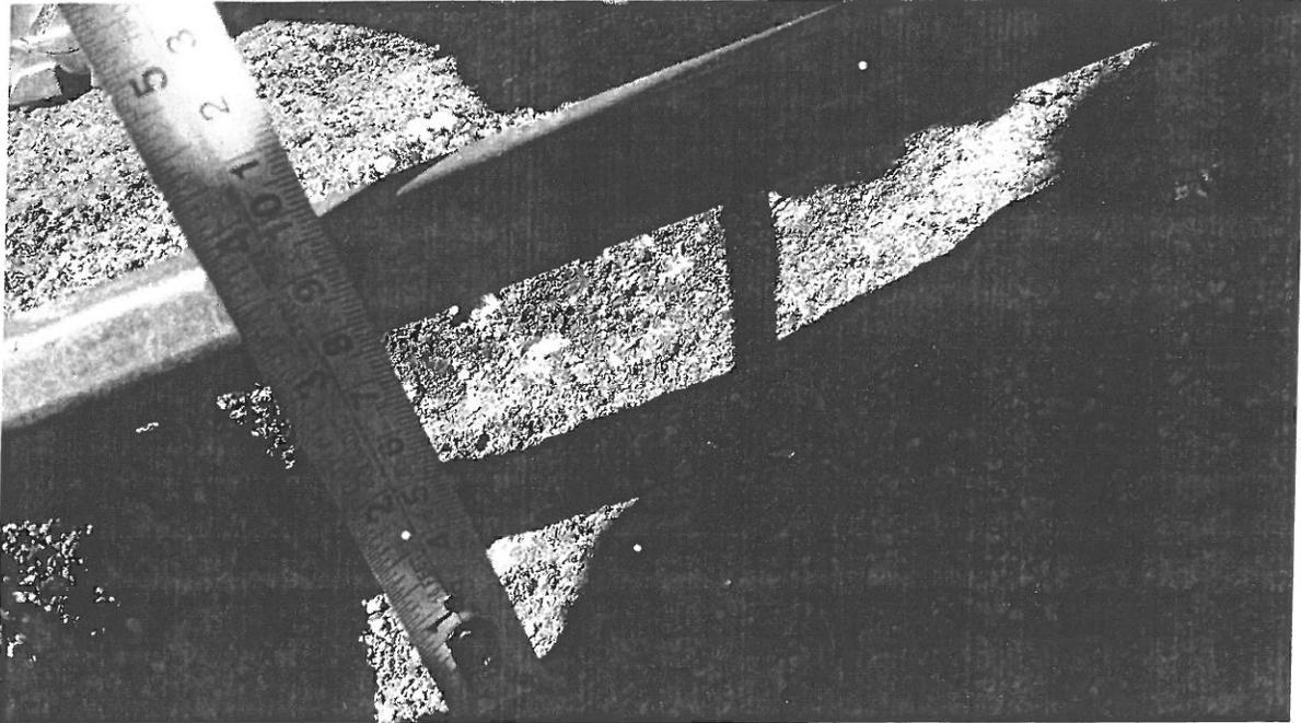
EN LAS TOMAS FOTOGRAFICAS SE APRECIA A PERSONAL DE LA JUNTA DE CAMINO DEL ESTADO DE SONORA Y DE CONTRALORIA, CHECANDO ESPESORES DE LAS CAPAS DE LA CARPETA ASFALTICA Y DE BASE HIDRAULICA, LAS CUALES CORRESPONDEN A LO ESPECIFICADO EN PROYECTO.
