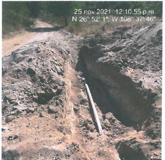
VISTA DE ZANJA Y COLOCACIÓN DE TUBERÍA DE PVC DE 3"
