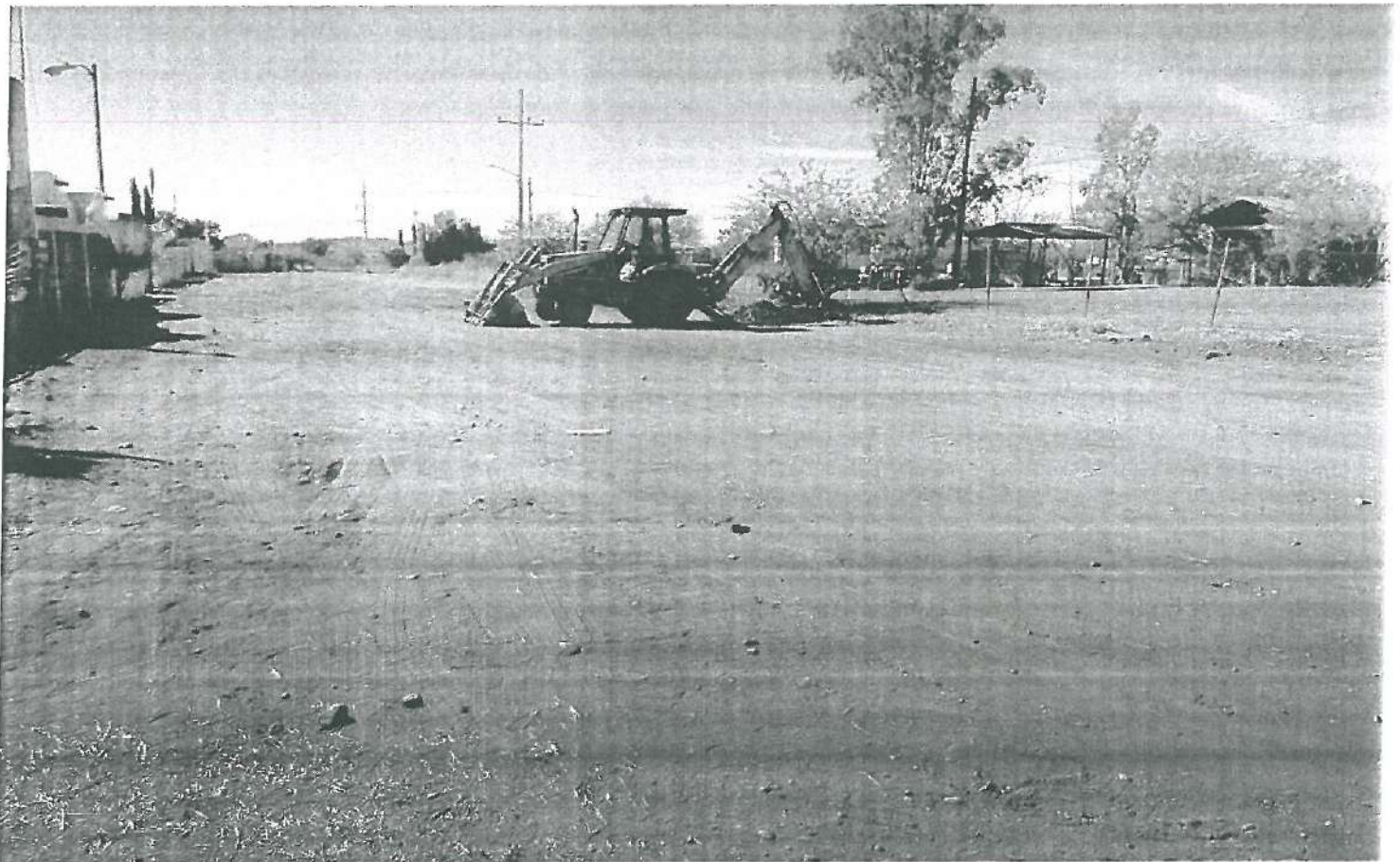
Vista panorámica del sitio de la obra.
