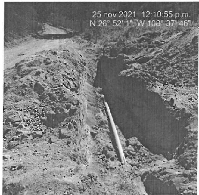
VISTA DE ZANJA Y COLOCACIÓN DE TUBERÍA DE PVC DE 3"
