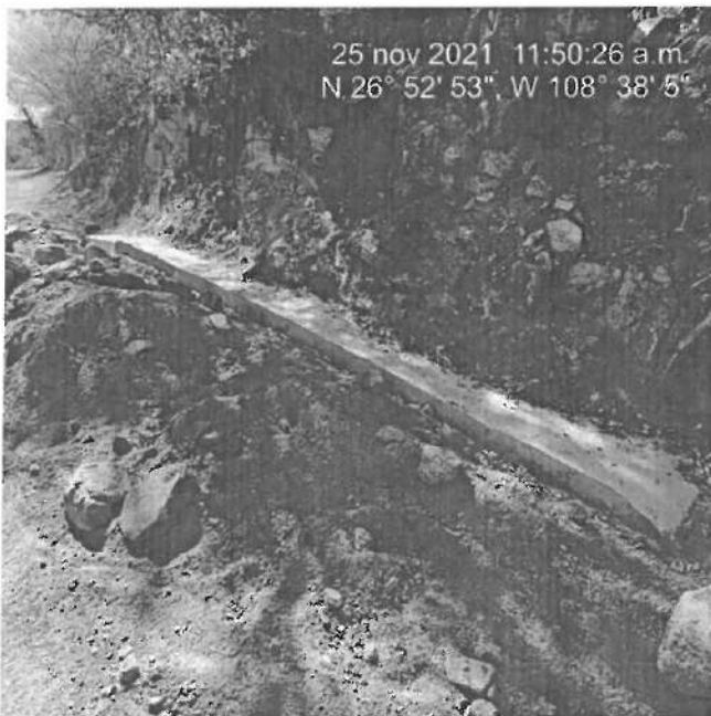
VISTA DE ENCOFRADO PARA LA RESISTENCIA AL GOLPE DE ARIETE
