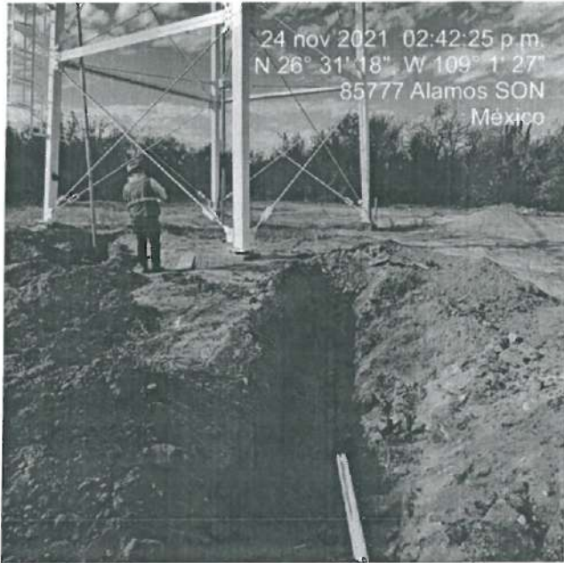
VISTA PANORAMICA DE TANQUE ELEVADO
