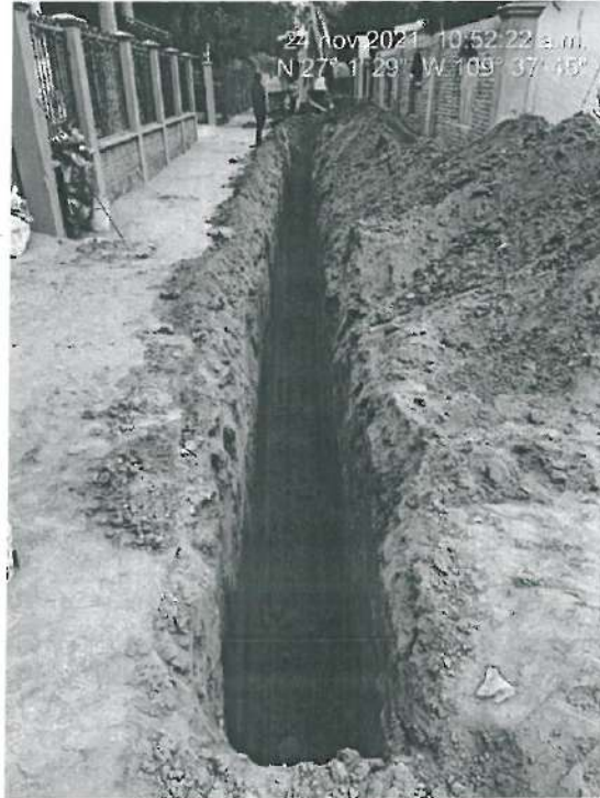
VISTA PANORAMICA DE EXCAVACIÓN PARA COLOCACIÓN DE TUBERIA DE 6"
