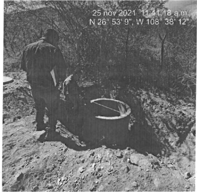
VISTA DE REGISTRO PARA VALVULAS DE ALIVIO
