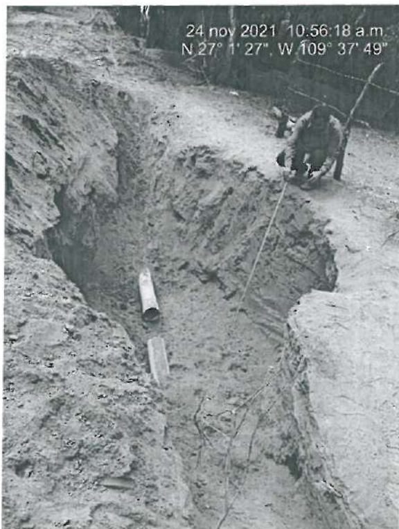
VISTA PANORAMICA DE EXCAVACIÓN PARA COLOCACIÓN DE TUBERIA DE 6"
