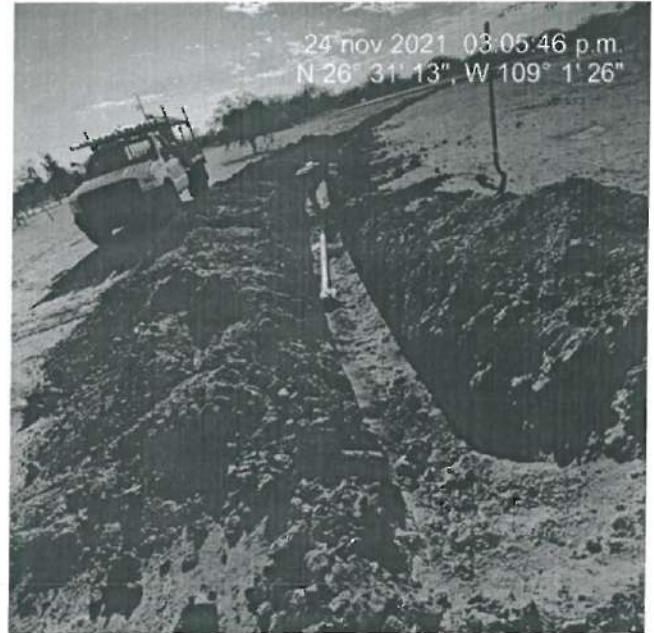
COMPACTACION DE LA LINEA DE AGUA
