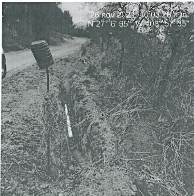
ZANJA Y COLOCACIÓN DE TUBERÍA DE PVC DE 3"
