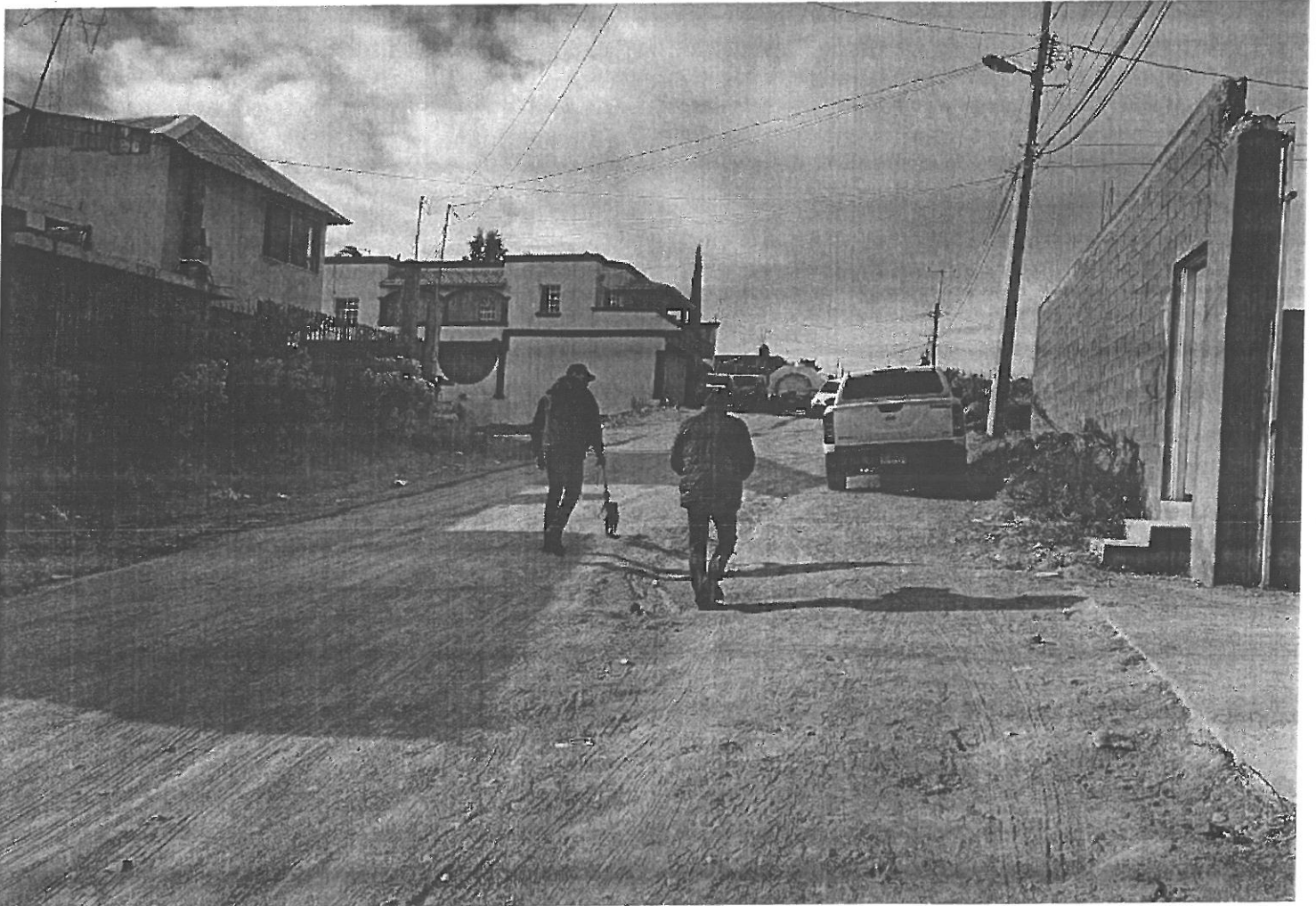
Vista panorámica del sitio de la obra.
