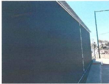
Colocación de malla sombra para protección de equipamiento.
