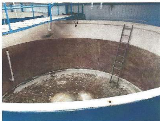
Antes y después de la limpieza mecánica y aplicación de pintura epóxica en tanques de reproductores.
