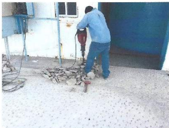
Durante y después de la demolición y suministro de concreto en área de equipos exteriores al cuarto de reproductores.
