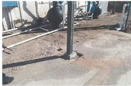
Zapata aislada de 0.45 x 0.45 m
