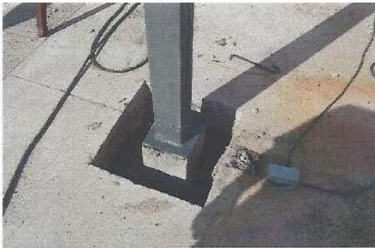
Zapata aislada de 0.45 x 0.45 m
