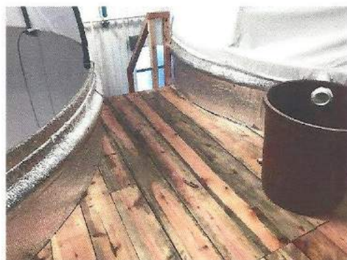
Construcción de andamios de madera para monitoreo y alimentación de reproductores.
