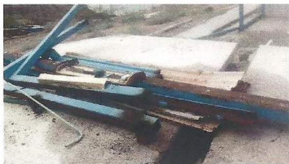
Desmantelamiento de cubierta a base de lámina galvanizada y estructura de polinera.
