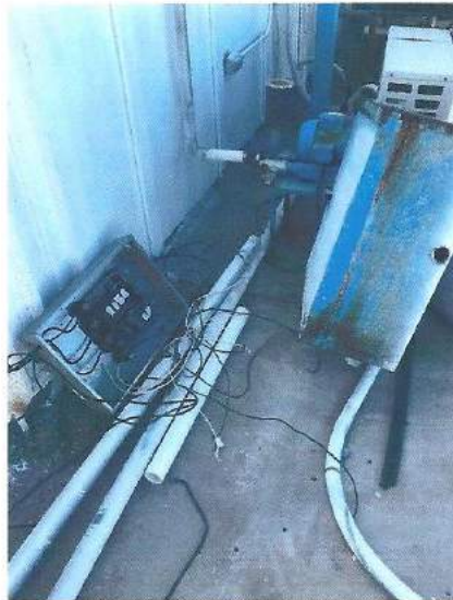
Desinstalación de equipo existente.
