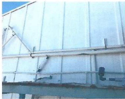
Aplicación de pintura en muro de área de reproductores
