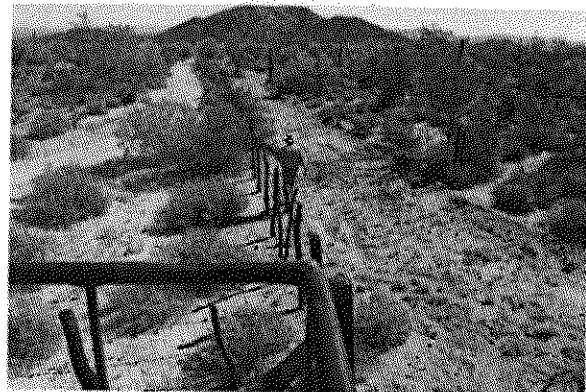
Verificación de puntos en cerco perimetral
