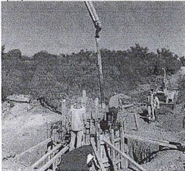
Colocación de concreto premezclado para fabricación de cárcamo de bombeo
