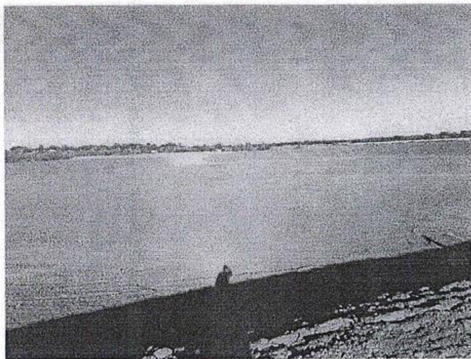
FORMACION DE BORDOS EN LAGUNA DE OXIDACION Y CAPA DE ARCILLA IMPERMEABLE
