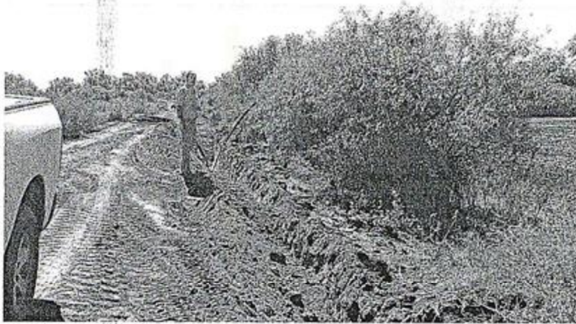
Cepa con tubería de 3 plgs.
