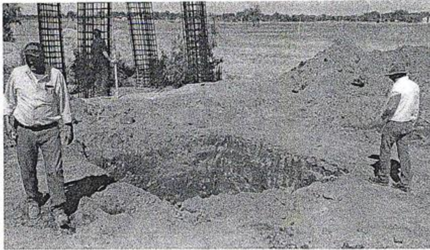
Excavación para cimentación tanque Rahum
