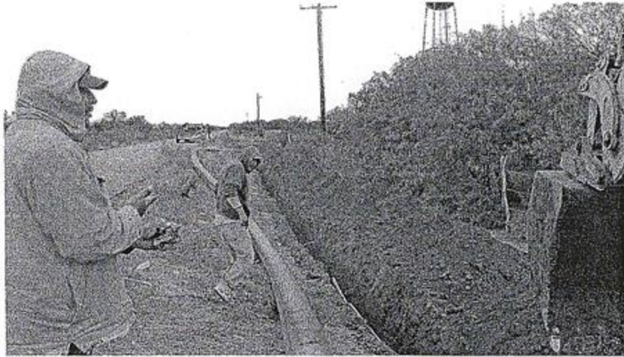
Colocación de tubería de 10 pulgadas.
